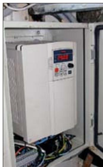
Z-образная тестомесилка пряничного теста и преобразователь Веспер при ней, управляющий двигателем. Ему задается две скорости, потому что в определенный момент легче, а в другой тяжелее повернуть тестовую массу
