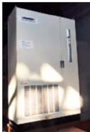
Самый мощный агрегат завода - жом-пресс и 500 кВт-ный преобразователь Веспер, который управляет работой его двигателя. Внизу: щитовая котельной. Преобразователи управляют двигателями дымососов и вентиляторов
