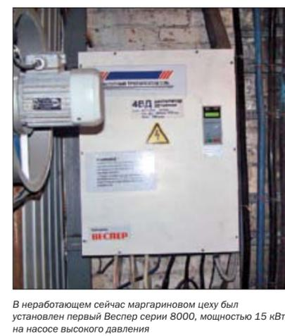
В неработающем сейчас маргариновом цеху был установлен первый Вespера серии 8000, мощностью 15 кВт на насосе высокого давления
